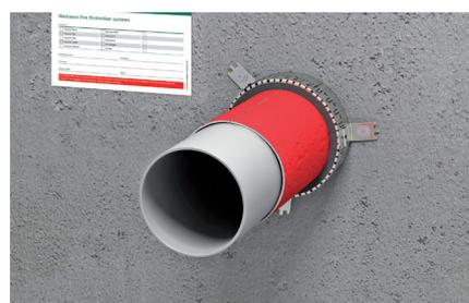
9. Placez ensuite la carte d'identification Pacifyre® complétée sur le mur, sur le plafond, ou sur la canalisation, pour identification lors de l'inspection.
