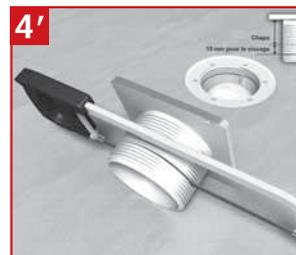
**4'** En fonction de l'épaisseur du carrelage, recouper la rehausse en laissant les 15 mm nécessaires au vissage.
