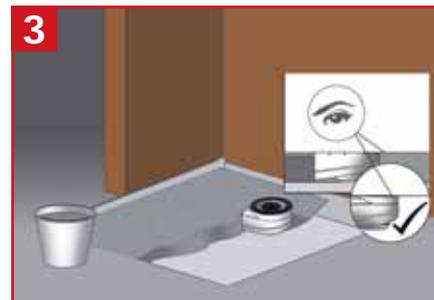
**3** Couler la chape de ciment autour de la bonde et du tube de raccordement.
