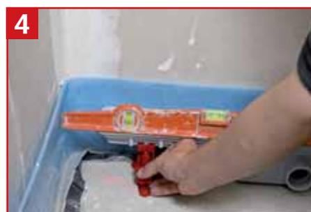
**4** Régler la hauteur et ajuster le niveau.
