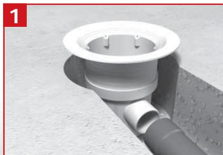
**1** Mise en place du siphon. Pour les versions SITAR et SITARAL, coller le bouchon dans la sortie non utilisée.
