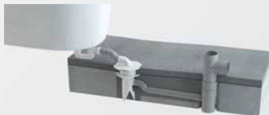
9 - Positionner la réhausse et couler la chape avec une forme de pente de 1% minimum
