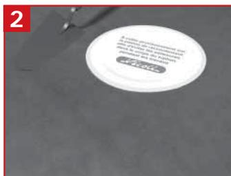
**2** Coller le film de protection. Réaliser la pré-chape comblant la dalle
