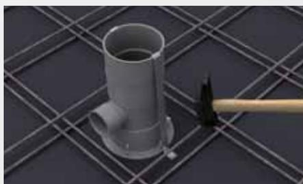
5 - Clouer l'embout de coffrage Ø100 au plancher
