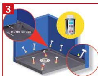
**3** Positionner le film proprement, faire remonter les bords sur 3 à 4cm au dessus de la hauteur de chape prévue, effectuer un pli mouchoir dans les angles. Coller seulement les bords de film au mur et le pli mouchoir.
