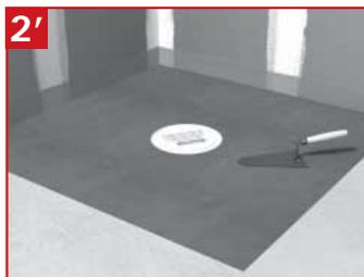
**2'** Coller le film de protection. Réaliser la chape avec une forme de pente de 1% minimum comblant la dalle
