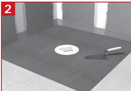
**2** Coller le film protecteur sur le corps du siphon. Comblar la réservation avec du béton de remplissage et raser à la hauteur du siphon sans son joint.
